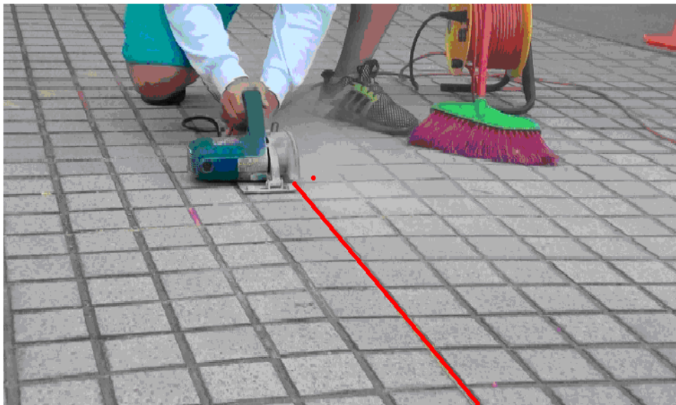
圖 26 割除地磚縫隙圖
