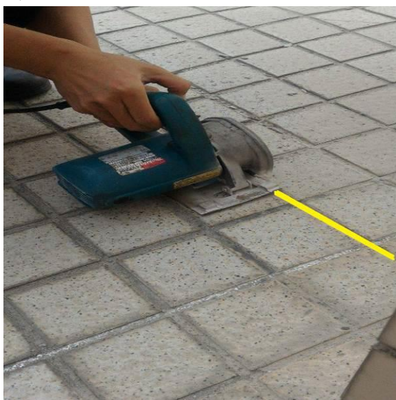
圖 18 割除地磚縫隙圖
