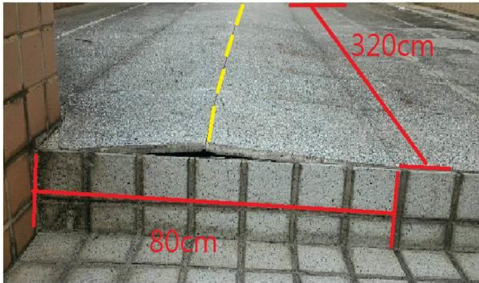
圖 11 施工現場評估圖
