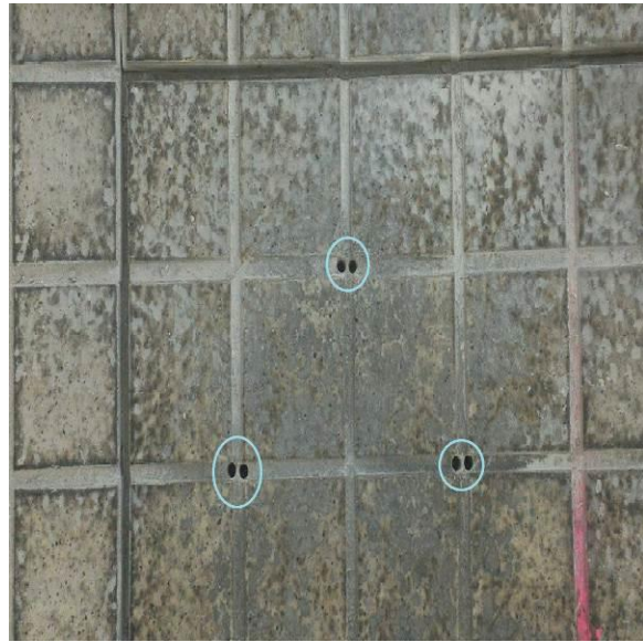
圖 21 灌注孔詳細位置圖
