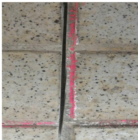
圖 19 割除後的減壓縫隙詳圖
